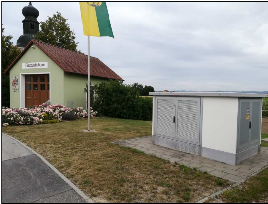
Blick auf Trafohaus und Feuerweh- haus im Westen der Fläche
